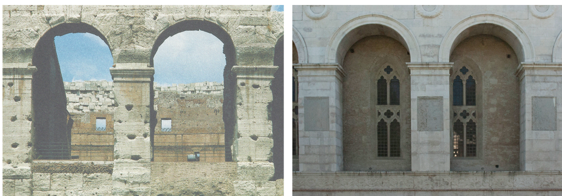
Figura 90. (À esquerda) Roma, Coliseu, detalhe da arcada, fonte: (Grassi, 2015, p. 35). (À direita) Rimini, T. Malatestiano, vista de pormenor da arcada da fachada lateral (Oeste).
