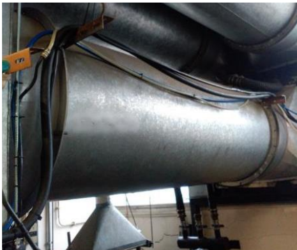
Figura 39 - Colocação do novo sistema de fornecimento
