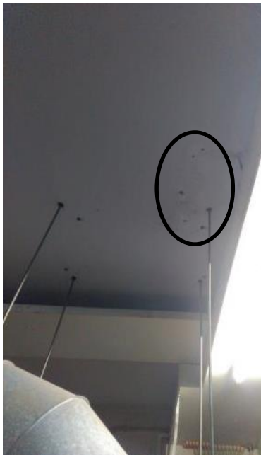
Figura 42 - Furos relativos à antiga instalação da linha de escape
