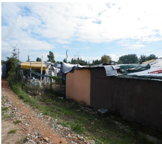
Fig. 1. Acesso ao acampamento.
