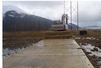
b) Estrada pantanosa pavimentada com GFFW
