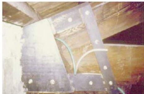
Figura 75 - Rigidificação de uma ligação originalmente semi-rígida (Piazza, 2004).
