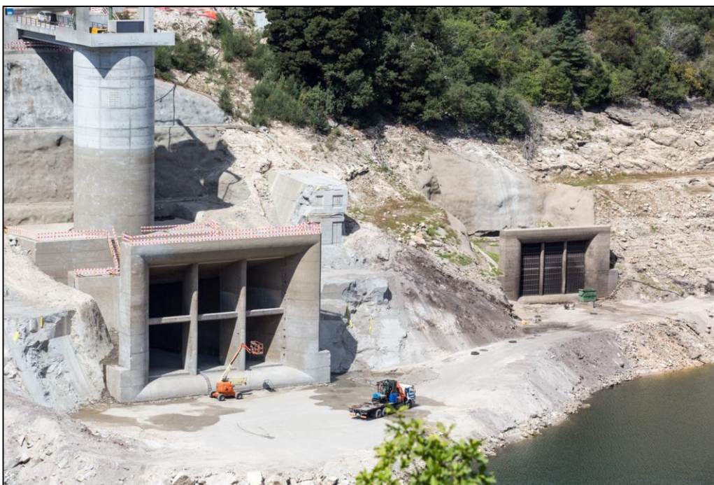
Figura 3.29 - Tomada de água de Venda Nova III, à esquerda (EDP, 2014).
