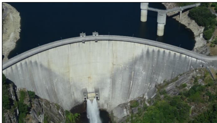
Figura 2.9 - Barragem do Alto-Lindoso - abóbada de dupla curvatura (Eido do Luou, 2015).
