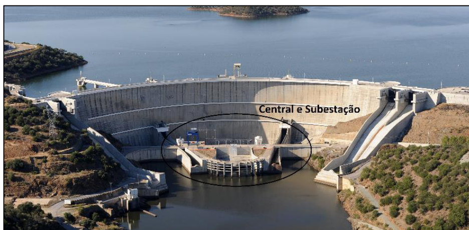
Figura 2.14 - Barragem de Alqueva - central pé-de-barragem, (EDP, 2009).
