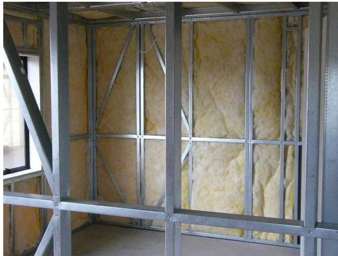
**Figura 16 - Lã de rocha aplicada entre perfis de aço (Fonte: Futureng 2013)**
