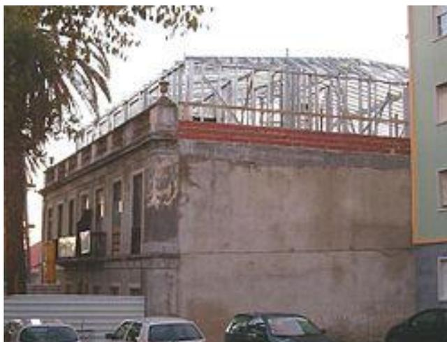
Figura 13 - Reabilitação utilizando LSF (Fonte: Futureng 2013)
