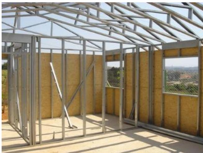
**Figura 15 - Aplicação de revestimento OSB (Fonte: Futureng 2013)**
