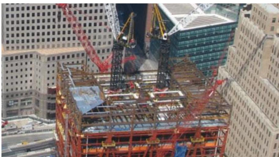
**Figura 10 - Uso de estrutura metálica na construção (Fonte: Dmoz 2015)**
