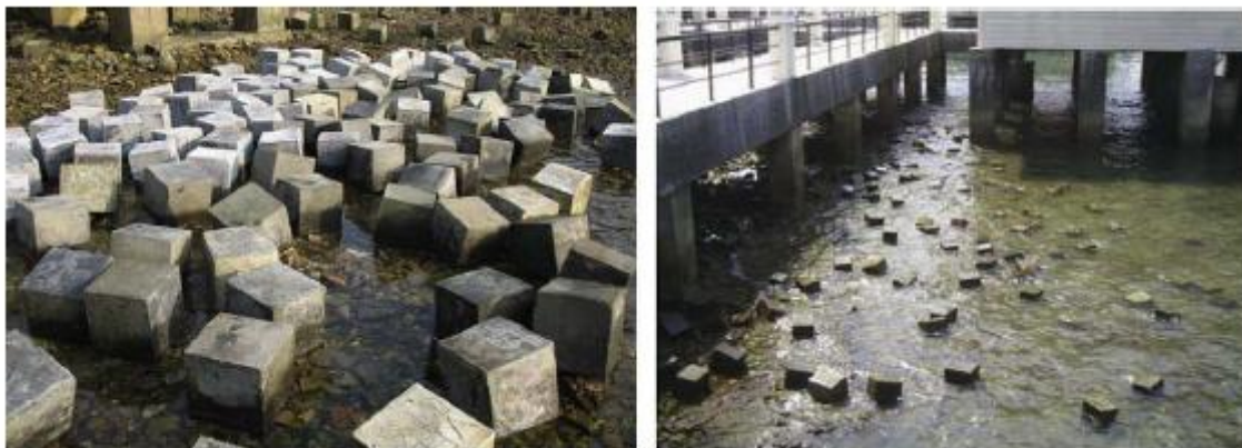
Figura 13: Amostras de betão em uma zona de maré, no Golfo da Tailândia, Chonburi Província (Chaleea et al. , 2010).
