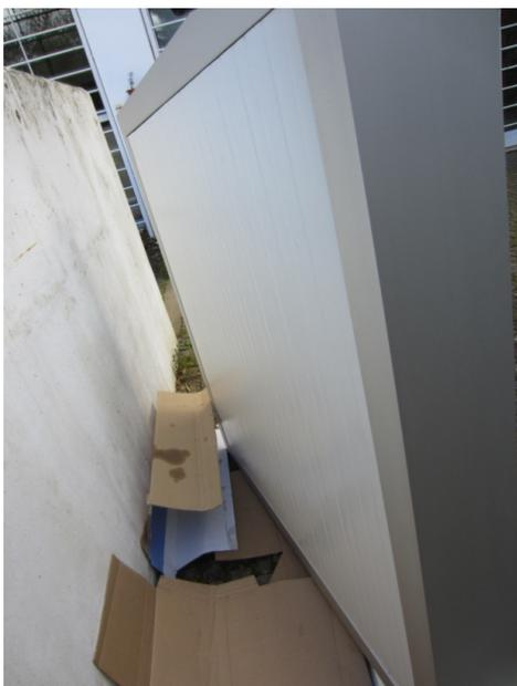
Figura 78 – Parte posterior do sistema que mostra a ligação entre o caixilho de alumínio e o painel sandwich, que deverá ser selado com silicone.
