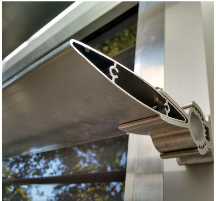
Figura 82 - Pormenor do sistema de sombreamento fixo.
