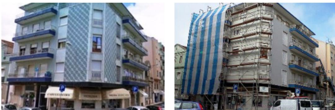
Figura 32 - Antes e depois da aplicação de um sistema ETICS (Oficinadeobras, 2015).
