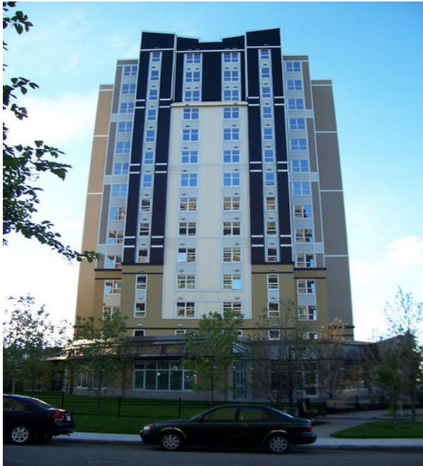
Figura 21 - Exemplo da utilização do sistema “solar Wall” em edifícios residenciais (Manchester Housing, AB Canada), os painéis são a parte escura na fachada do edifício (Conserval Engineering Inc.).
