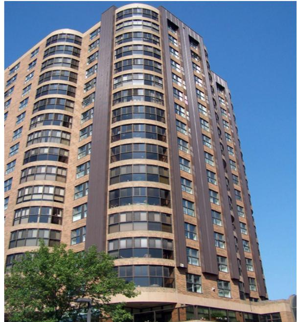
Figura 22 - Exemplo da utilização do sistema “solar Wall” em edifícios residenciais (Fred Douglas Building, MB – Canada). Os painéis são as linhas verticais escuras, na parte opaca da fachada (Conserval Engineering Inc.).
