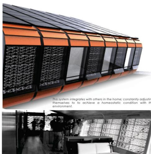
Figura 16 – Vista exterior e interior da parede solar de água, fonte (Hall, Edward G.).
