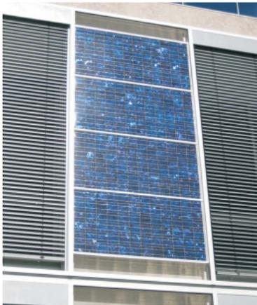
Figura 28 – Painéis fotovoltaicos vistos pelo exterior no edifício Solar 21. Na parte inferior e superior do painel é possível ver as grelhas de ventilação (Ineti, Dez 2005).
