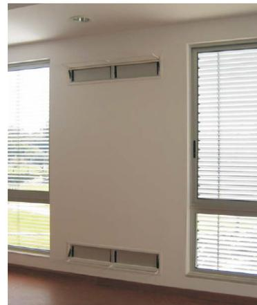
Figura 29 – Vista pelo interior do sistema, são visíveis as aberturas de ventilação inferior e superior (Ineti, Dez 2005).
