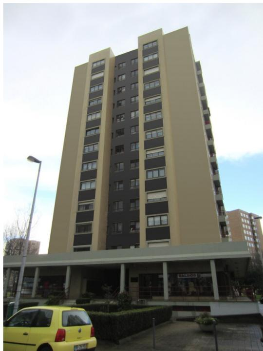
Figura 73 - Previsão de aspeto após intervenção, com aplicação de sistema ETICs, sistema de captação solar ativo e alteração de esquema de pintura.
