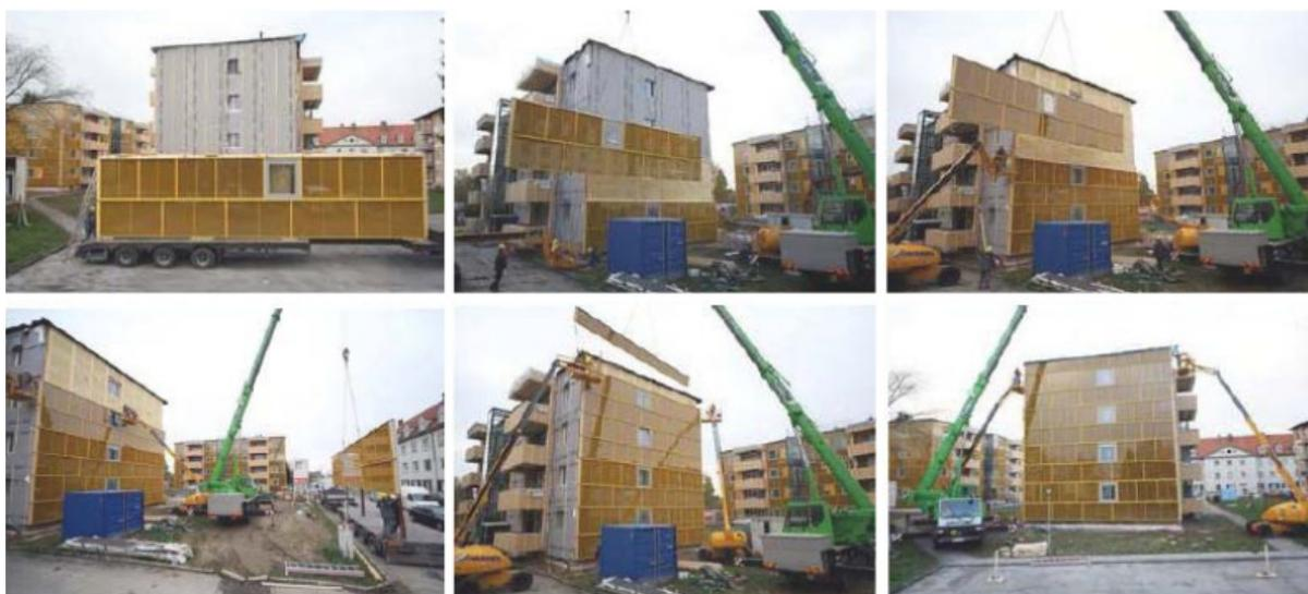
Figura 33 - O sistema de fachada GAP vem já pré preparado de fábrica sendo apenas assemblado no local da obra (gap-solution, 2014).
