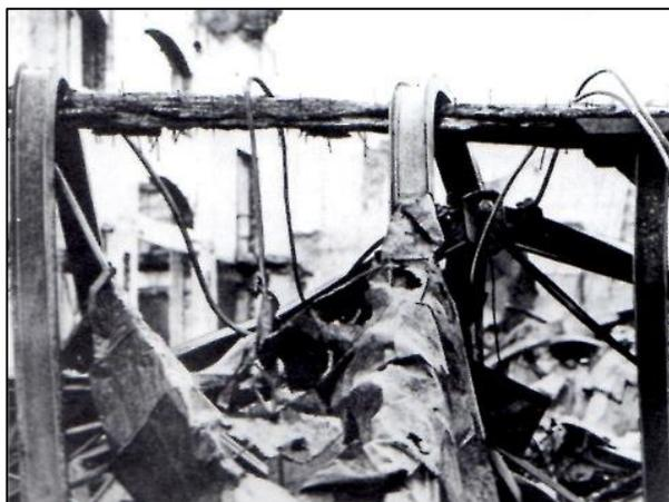
Figura 2-1: Comparação entre uma viga de madeira e uma viga de aço após um incêndio (Moura Pinto, 2004)
