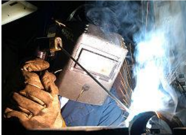
Figura 3.11 - Soldadura por Eléttodos Revestidos
