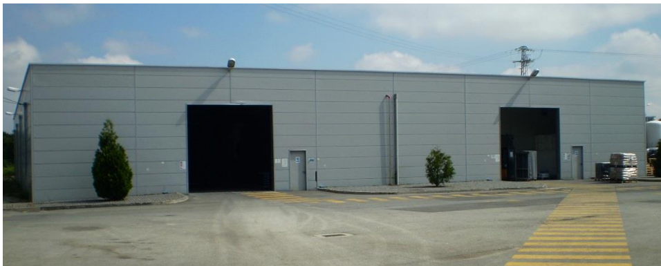
Figura 18 - Fachada do Armazém 3
