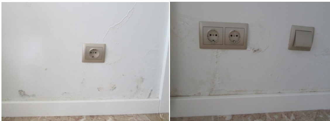
Figura 27 – Parede da sala da habitação 2
