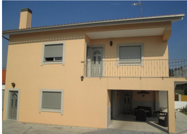
Figura 11 – Fotografia da habitação 1
