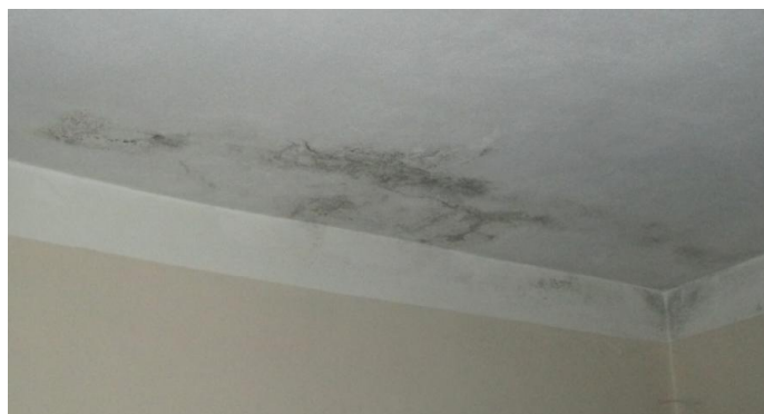
Figura 25 - Vista interior do teto da sala da habitação 1
