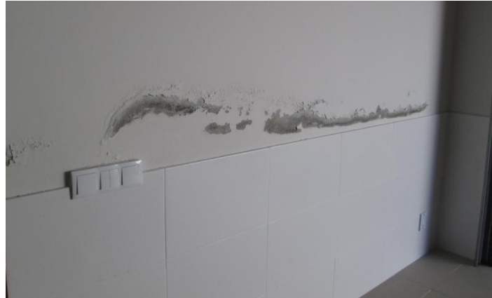
Figura 28 – Parede da garagem da habitação 2
