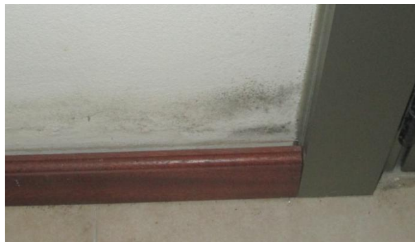
Figura 26 – Vista interior do rodapé da parede da sala, habitação 1
