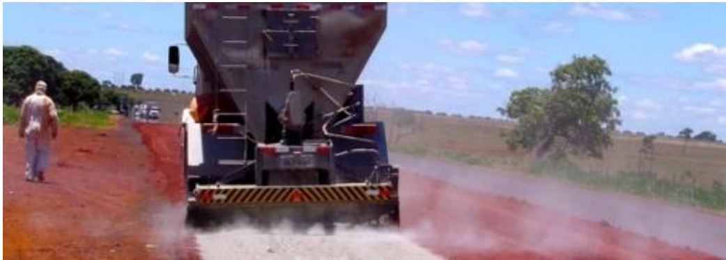
Figura 5 - Espalhamento do cimento sobre o solo a estabilizar (Fresar, 2004).
