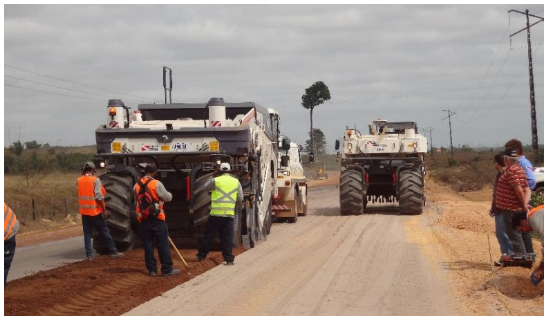
Figura 6 - Mistura do cimento com o solo a ser estabilizado (Ciber, 2013).
