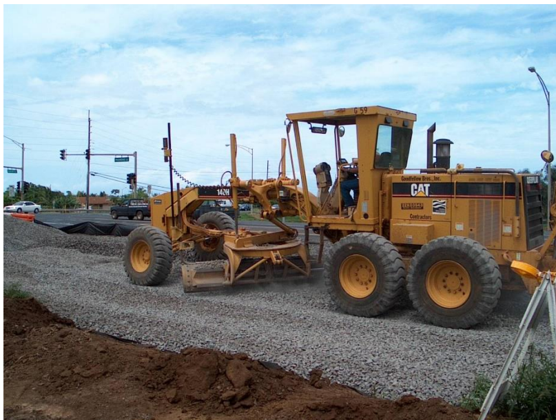
Figura 4 - Camadas Granulares de um Pavimento Rodoviário (Interactive, 2013).
