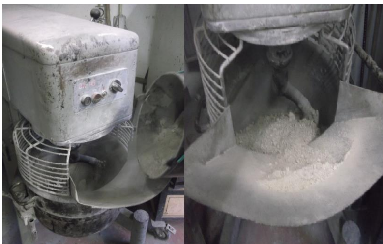
Figura 17 - Mistura da amassadura de uma laje.
