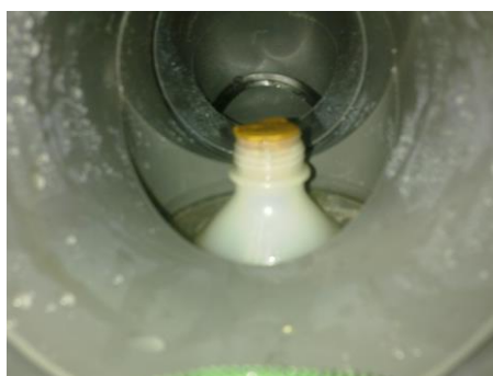
Figura 4.9 – Funcionamento do tampão com o Segundo Depósito de Águas de Lavagem cheio A extremidade a jusante do “T” esta ligada a um “Curva” em PVC com 110 mm.
