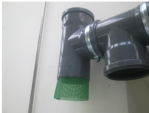
Figura 4.3 – Aplicação da rede/filtro
