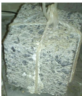
Figura 4.14 – Provete de betão revestido com tinta acrílica após 3 dias de contacto com o ácido sulfúrico (C=30%)
