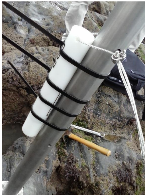
Figura 9 2º e 3º Passo, Colocação das abraçadeiras e cabo de segurança
