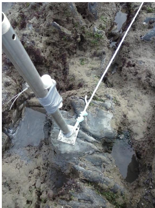
Figura 11 5º Passo, Colocação da corda de marinheiro na estrutura
