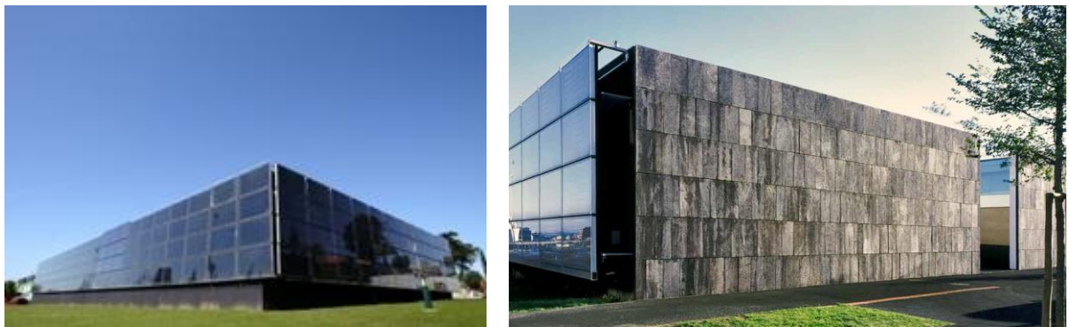
Figura 28 - Coletores integrado no revestimento da fachada (GRAÇA, 2014)
