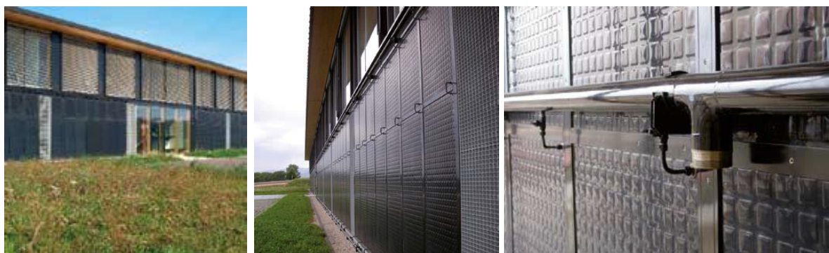
Figura 29 - Integração direta na fachada - Centre d' exploitation des Routes Nationales (CeRN), na Suíça (NIV-O, 2007)
