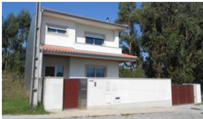
Figura 31 - Vista do Alçado Principal do edifício
