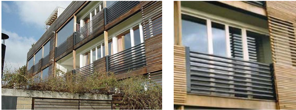
Figura 30 – Integração em grade de varanda - Sunny Woods, Zurich, Suíça, (SHC, 2014)
