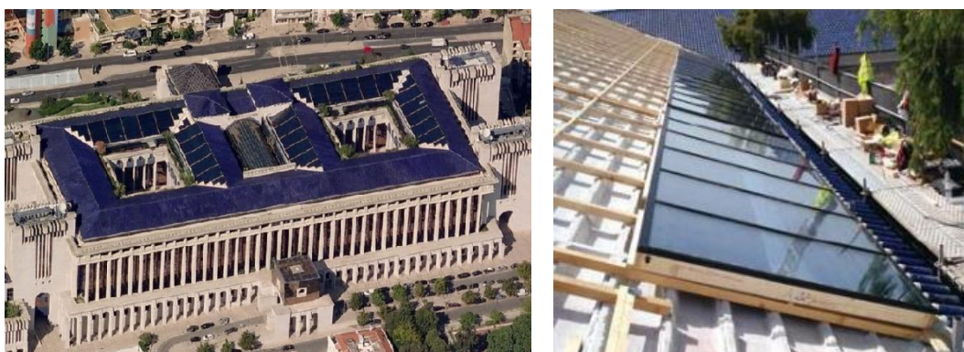
Figura 27 - Coletores integrado no revestimento da cobertura (CGD, 2014)
