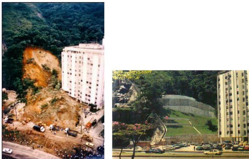
Figura 2.1 - Deslizamento de um talude (à esquerda) e posterior estabilização (à direita) (adaptado de GersCovich, 2009)
