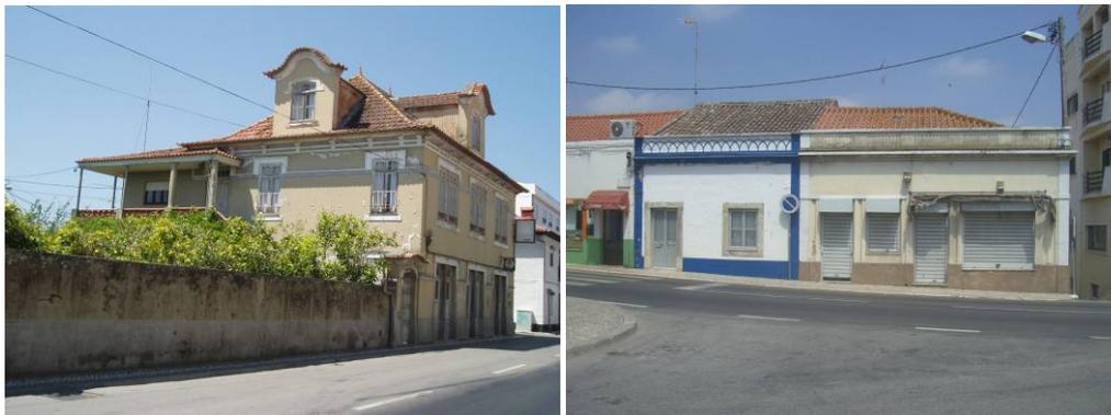
*Figura 7 (a) Gafanha da Nazaré, pensão/padaria construída em adobe e que substituiu a casa unifamiliar pré-existente (b) Casas em Benavente reforçadas com platibanda e esticadores. Créditos Maria Fernandes, 2007 e 2012.*
