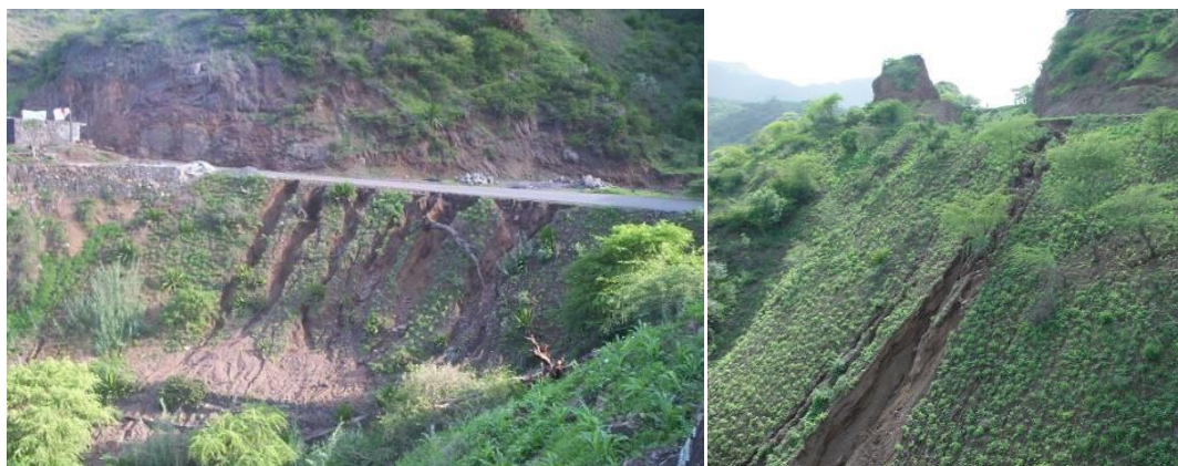
Fotografias 4 e 5. Formações de ravinas e voçorocas seguidas a escorregamento na zona dos Picos. Fonte: Autora.
