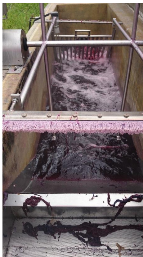
Figura 36 - Gradagem e tamização.
