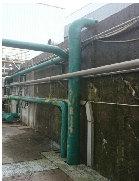
Figura 39 - Excesso de captação.
