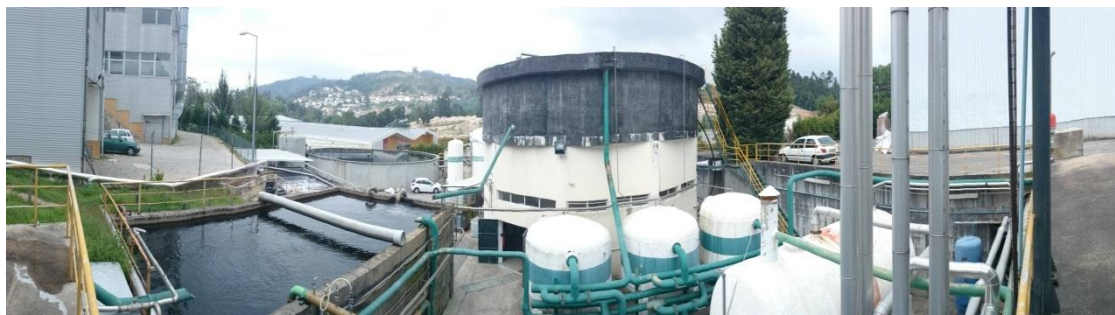
Figura 33 - Estação de tratamento de água da Mundotêxtil.
