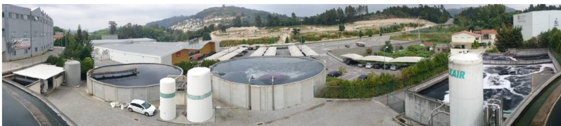
Figura 35 - Estação de tratamento de águas residuais da Mundotêxtil.
