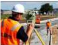
O teodolito é um instrumento de ótico de medida que se utiliza em várias áreas técnicas, em particular na topografia. Serve para determinar distâncias inacessíveis utilizando ângulos de elevação e ângulos de depressão.
