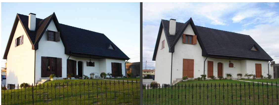
FIG. 38 – Alteração dos caixilhos na casa de Francisco, antes e depois
