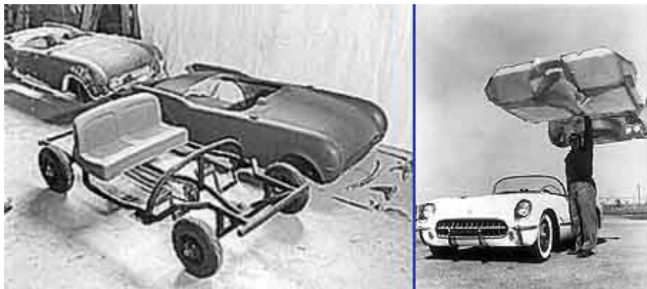
Figura 2-4 – Chassi e carroçaria do Chevrolet Corvette [12]
