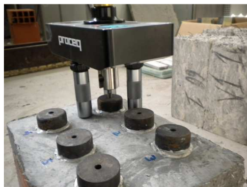
Figura 5.27 – Realização dos ensaios de pull-off com equipamento de arrancamento
