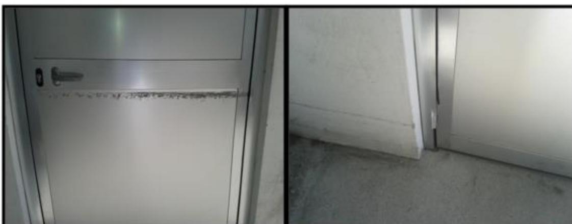
Figura 42 - Danos provocados por carros de transporte devido à largura da porta.
