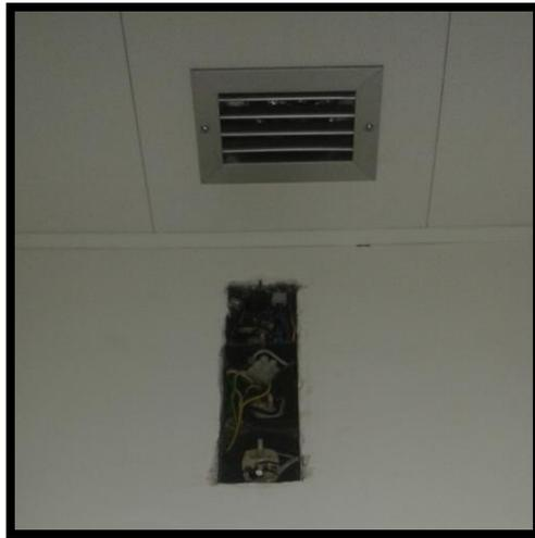
Figura 44 - Falta de isolamento dos condutores elétricos.
