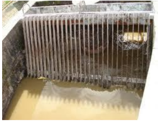
Figura 2.2 - Tratamento preliminar – gradagem. Disponível em http://ambienteeng.blogspot.pt/2009/01/ (consultado em janeiro 2013)
