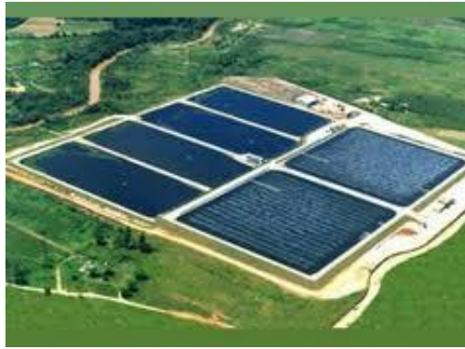
Figura 2.6 - Tratamento secundário – lagoas de estabilização. Disponível em http://www.infoescola.com/ecologia/biorremediacao/ (consultado em janeiro 2013).
