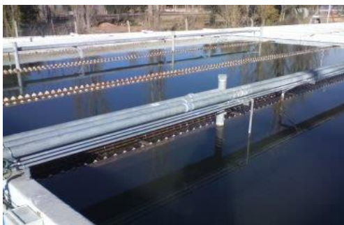
Figura 2.13 - Sedimentador rectangular. Disponível em http://www.aguaazulinternacional.com . (consultado em fevereiro 2013), e esquema de sedimentadores retangulares, Thomas, 2005
