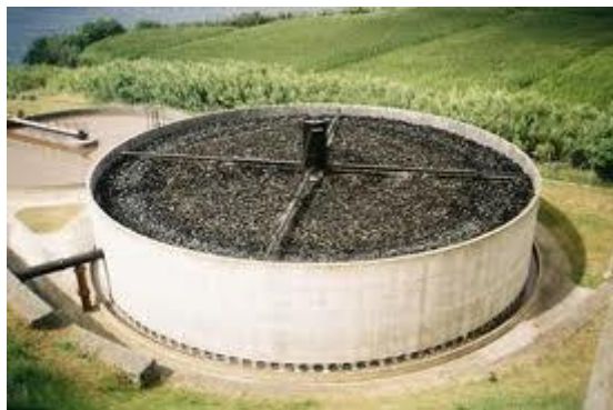
Figura 2.7 - Tratamento secundário- leitos percoladores. Disponível em http://www.cm-ah.pt (consultado em janeiro 2013)
