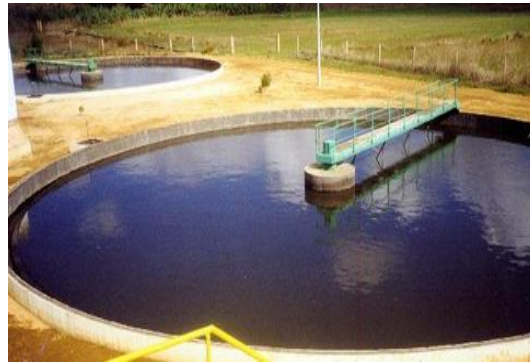
Figura 2.9 - Sedimentador primário. Disponível em http://csgquiagua.webnode.pt (consultado em janeiro 2013)
