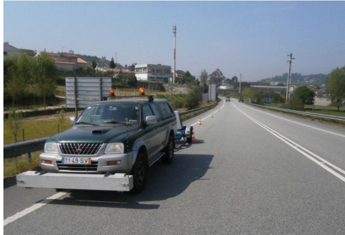
Figura 3.15 – Equipamento de ensaio e perímetro de segurança na secção 2
