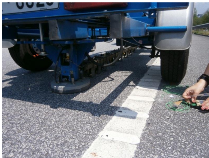
Figura 3.16 – Ensaio com defletómetro de impacto e medição da temperatura do pavimento
