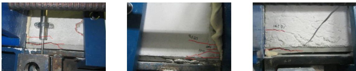
Figura 5.43: Fendilhação do Painel 3, após o primeiro ensaio
