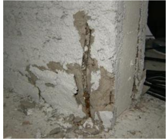
Figura 2.23: Canto com betão lascado (Pavesa e Bournas, 2011)
