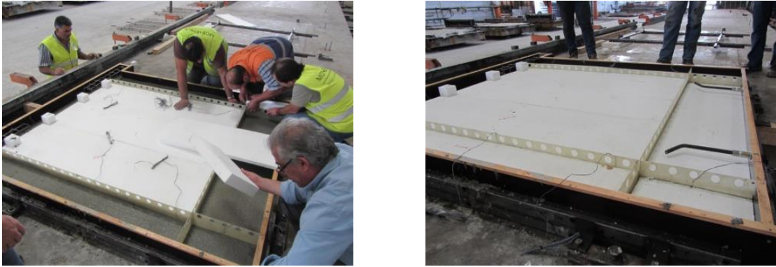
Figura 5.10: Posicionamento dos blocos de EPS no Painel 2
