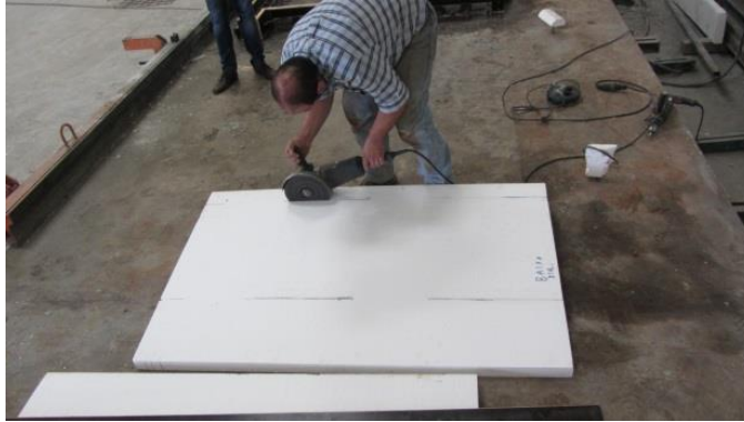
Figura 5.12: Recorte das placas de EPS
