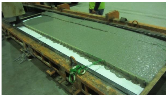
Figura 4.9: Passagem de betão com fibras pelos furos do conector
