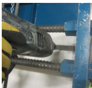
Figura 5.33: Furações para colocação da instrumentação
