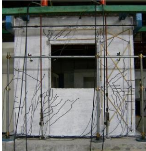
Figura 2.28: Fendas de corte paralelas à biela de compressão em paredes com janelas (Pavesa e Bournas, 2011)
