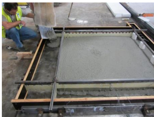
Figura 5.9: Betonagem da camada inferior, do Painel 2
