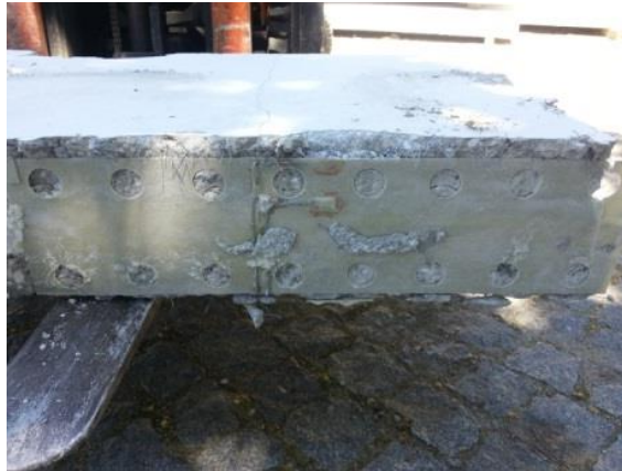
Figura 4.38: Rotura de um conector descontínuo CSM
