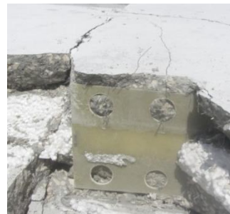
Figura 5.48: Fenda horizontal no limite do conector
