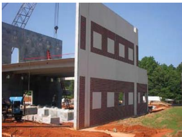
Figura 2.3: Estrutura com painéis sandwich de betão (Gleich, 2007)
