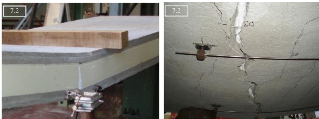
Figura 2.15: Ensaio de flexão: rotura da camada inferior de betão armado (Gara et al. , 2012)
