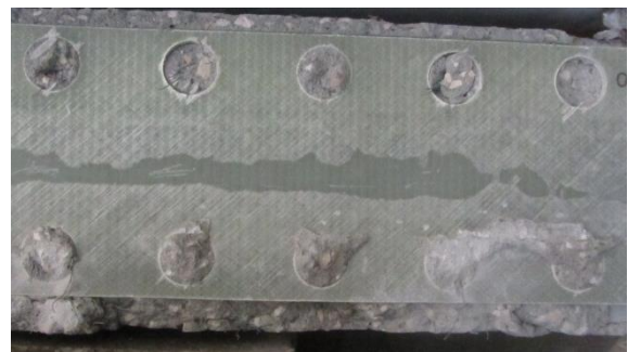
Figura 3.37: Preenchimento total dos furos com betão
