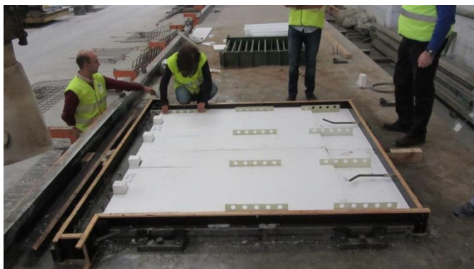
Figura 5.13: Colocação dos conectores
