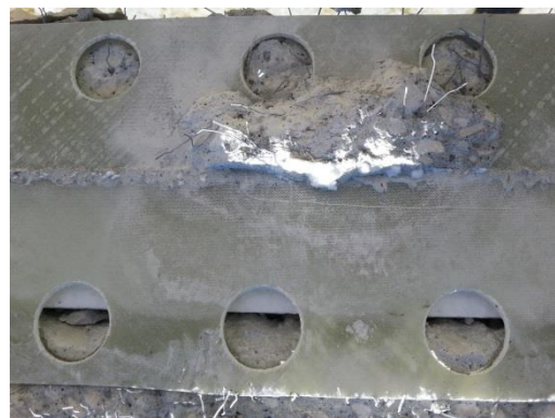
Figura 4.45: Defeito na betonagem do Provetete 5
