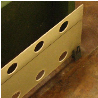
Figura 3.6: Espaçador de 15 mm Figura 3.7: Betonagem das vigas sandwich
