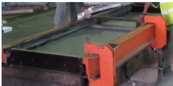
Figura 4.6: Nivelamento da camada inferior de betão
