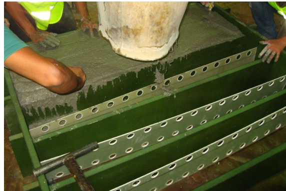
Figura 3.6: Espaçador de 15 mm Figura 3.7: Betonagem das vigas sandwich
