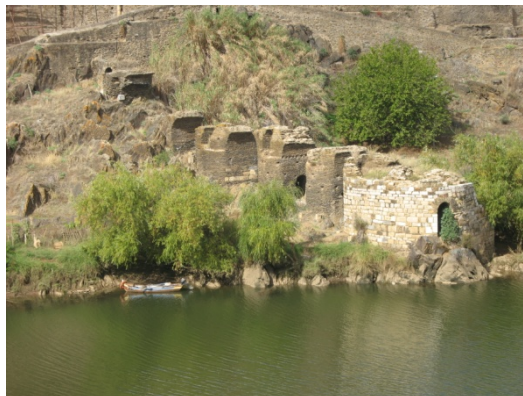
Figura 3.24 – Ponte de Mértola.
