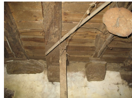
Figura 3.10 – Pavimentos em madeira (Vilar de Mouros).
