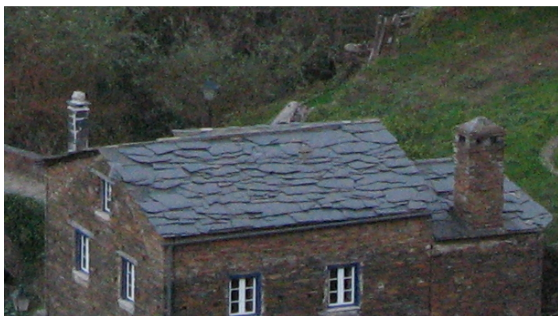
Figura 3.16 – Revestimento das coberturas das construções em xisto: a) com palha (Carrazedo de Montenegro); b) com ardósia (Piódão); c) com telha cerâmica (Carrazedo de Montenegro).
