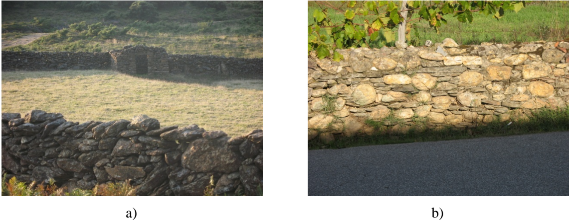
Figura 3.27 – Muros: a) muro e pequena construção executados com junta seca (Serra de Arga); b) muro executado com xisto e calhaus rolados de granito (Paul).
