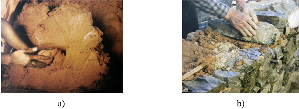
Figura 3.6 – Barro: a) barro amassado; b) assentamento do xisto (Ribeiro et al. , 2008).
