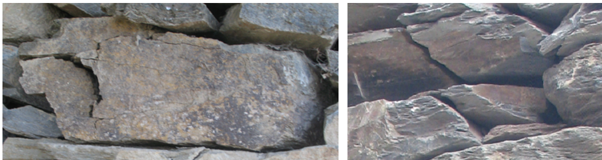
Figura 3.38 – Fratura de pedras de xisto (Carrazedo de Montenegro).
