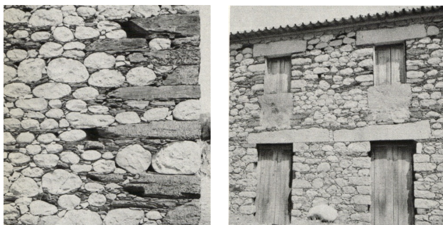
Figura 2.17 – Construção com mistura de xisto e calhaus rolados de granito (Associação dos Arquitetos Portugueses, 1980).
