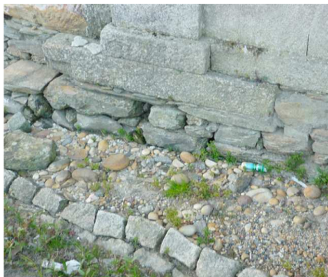
Figura 3.3 – Fundação superficial em xisto aparelhado numa construção em Barqueiros (Barroso, 2012).
