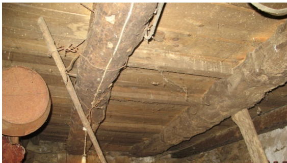
Figura 3.10 – Pavimentos em madeira (Vilar de Mouros).
