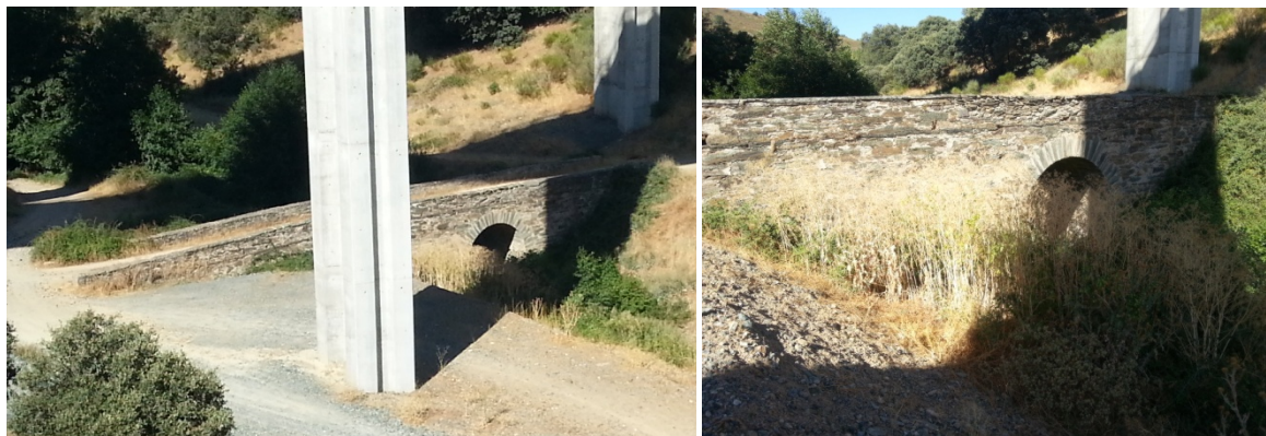
Figura 3.22 – Ponte do Porto, Milhão, Bragança.
