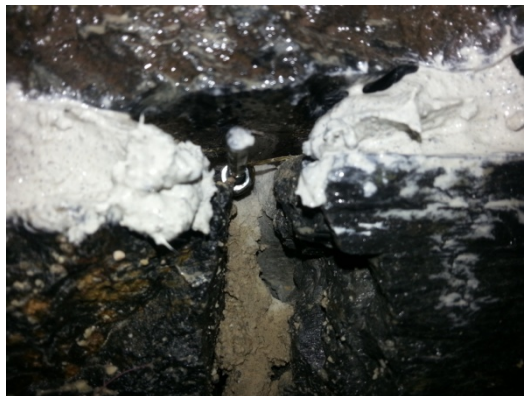
Figura 5.34 – Conexão entre varões roscados e cordões metálicos.
