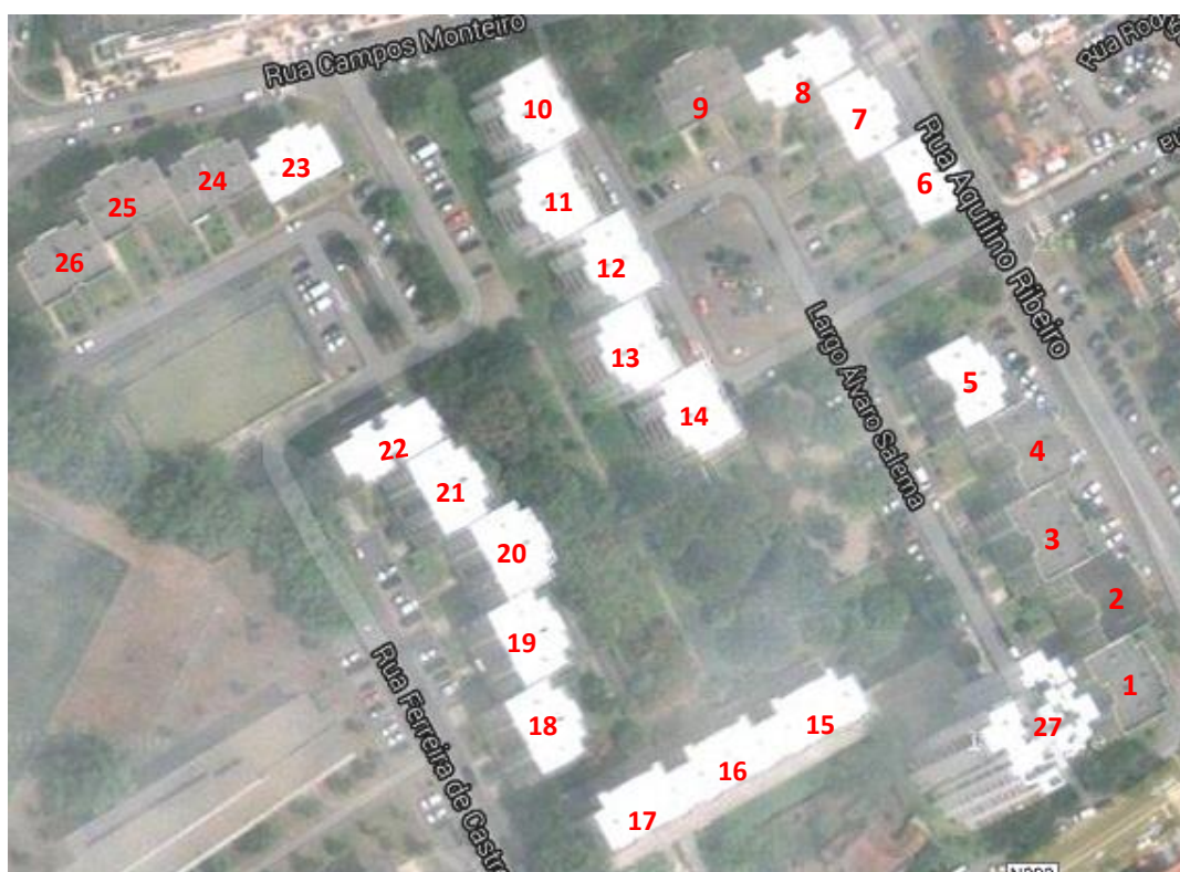
Figura 8. Vista aérea da Cooperativa Capitães de Abril
