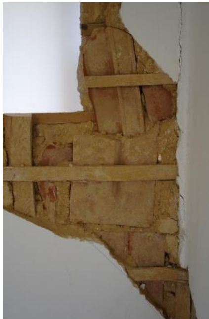
Figura 12 - Parede em Tabique (FC)
