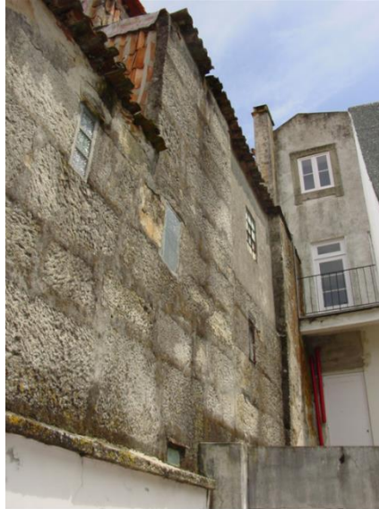
Figura 11 - Parede em Alvenaria de Pedra
