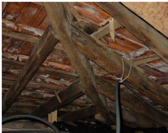
Figura 14 - Cobertura inclinada com estrutura em madeira
