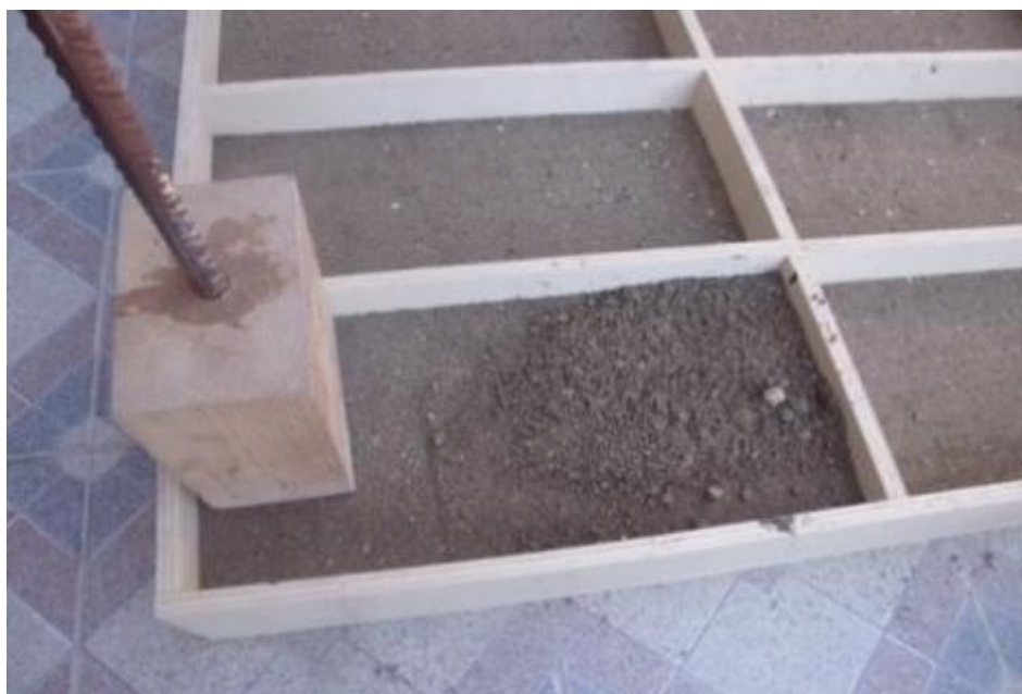
Figura 14 – Processo de compactação do solo.
