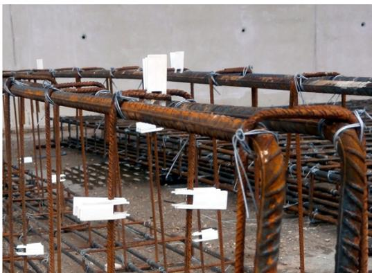
c) Espaçadores utilizados para garantir a espessura do betão de recobrimento (30 mm).
