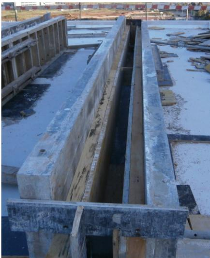
a) Cofragem utilizada na construção das vigas.
