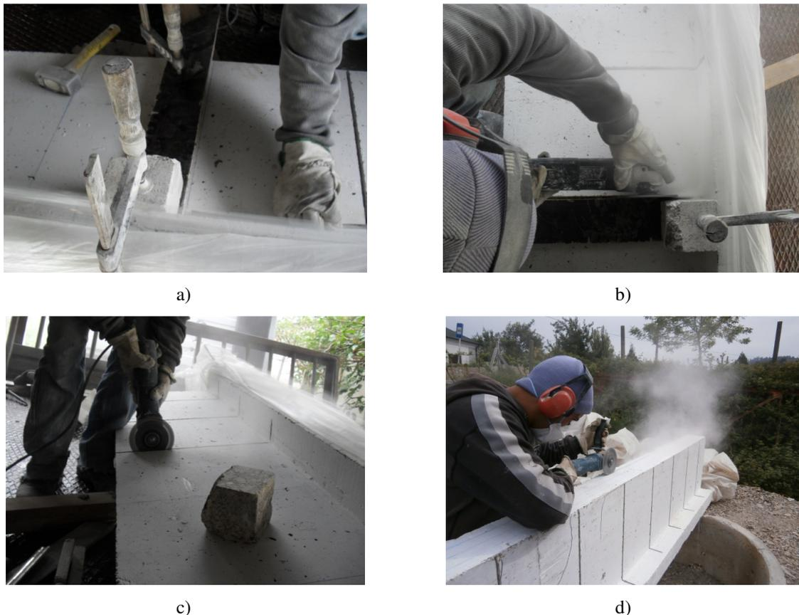
Figura 3.22 - Abertura dos entalhes transversais (a, b e c) e dos entalhes longitudinais (d).
