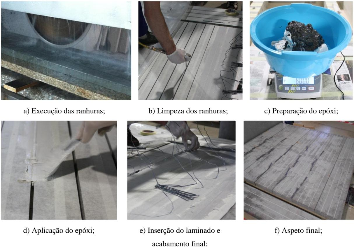
Figura 3.3 – Aplicação do reforço segundo a técnica NSM [18].
