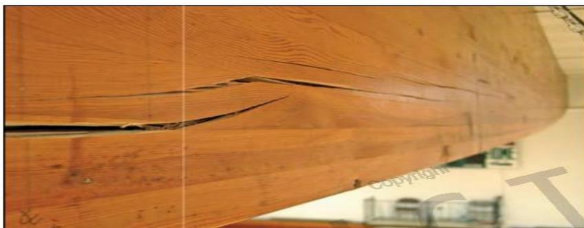
Figura 2.12 – Fendas longitudinais em viga de MLC (Gray e Gilham, 2006)
