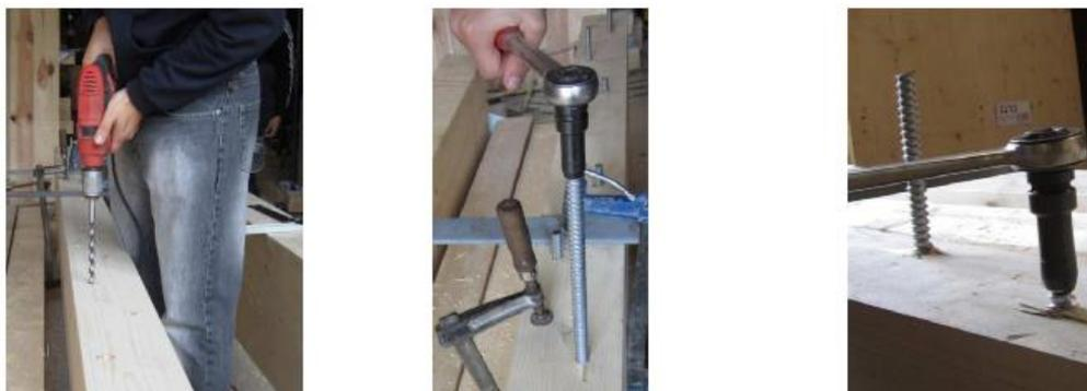
Figura 3.5 – Pormenorização da execução da pré-furação e colocação dos varões WB 16
