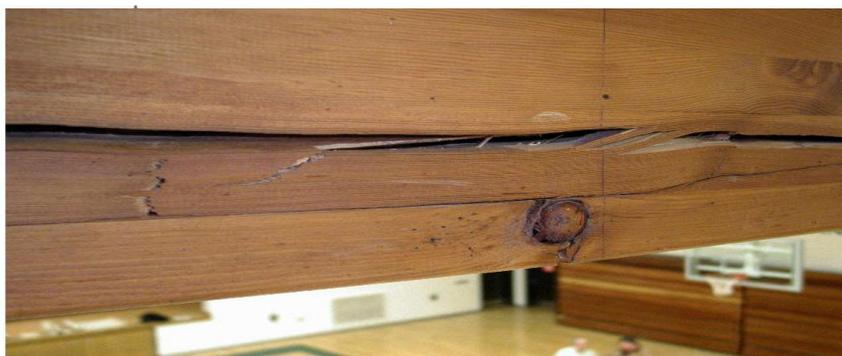
Figura 2.24 – Dano mais comum em vigas de madeira sujeitas à flexão
