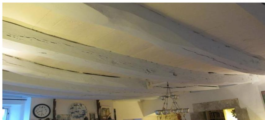
Figura 2.16 – Vigas com deformação excessiva
