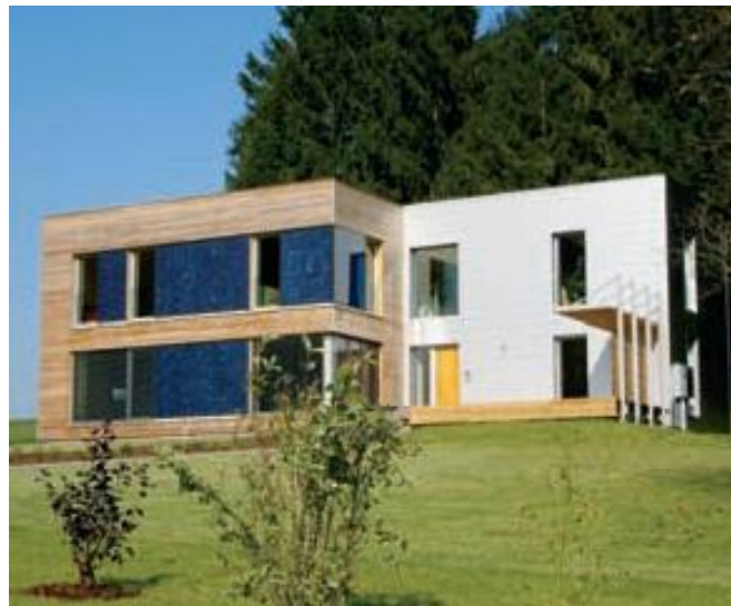
Figura 11 - Habitação reabilitada, Steinbruchweg, Áustria (Fonte: ISOVER).
