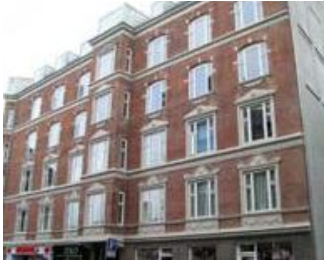
Figura 12 - Edifício reabilitado em Hellerup, Copenhaga, Dinamarca (Fonte: CO 2 OLBRICKS , 2012).
