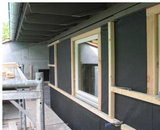
Figura 10 - Habitação unifamiliar alemã reabilitada, aspeto da alteração na envolvente (Fonte: Schirmer, 2011).
