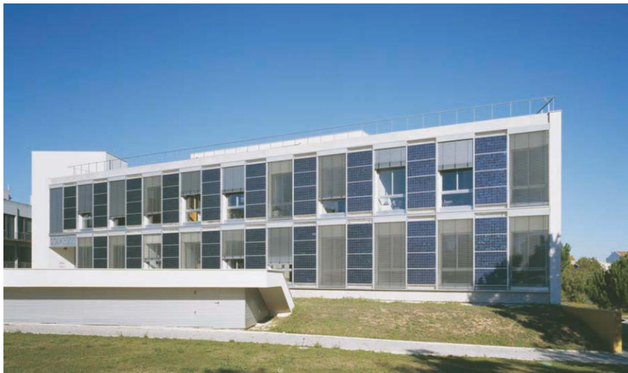
Figura 8 - Integração do sistema fotovoltaico na fachada do edifício Solar XXI, Campus do LNEG em Lisboa (Fonte: SOLAR XXI, 2010).
