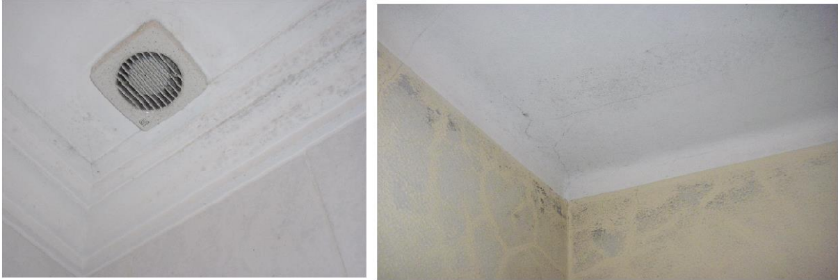
Figura 28 - Condensações em casas de banho
