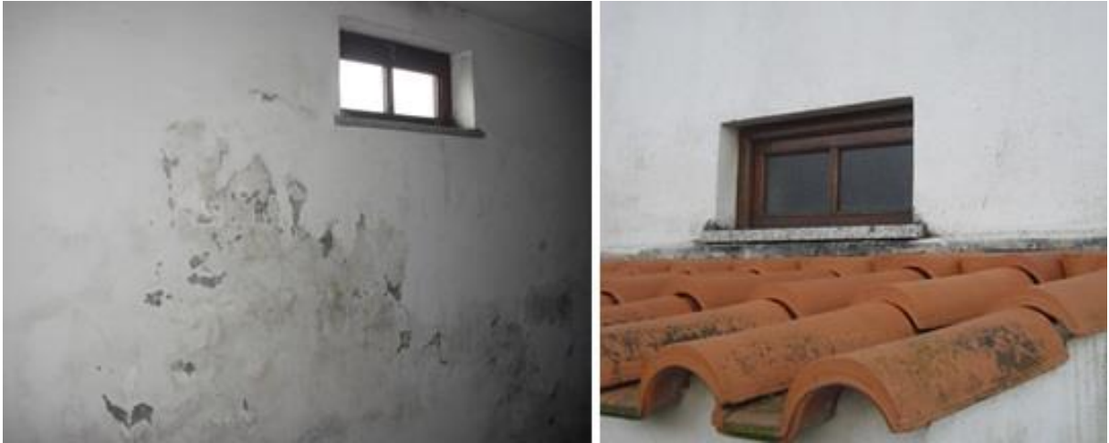
Figura 30 - Vista interior e exterior da fachada exterior da garagem
