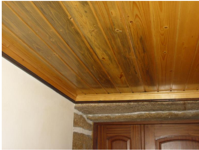
Figura 32 - Teto do corredor do rés-do-chão
