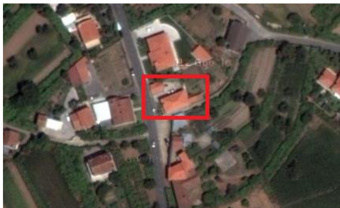
Figura 16 - Localização do edifício em estudo
