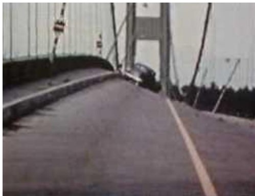
Figura 1 - Efeito de ressonância na ponte Tacoma Narrows (Battista, 2010).
