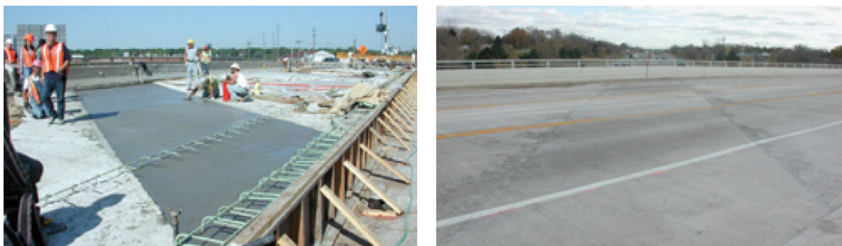
Figura 29 – Uma laje de ligação de ECC foi aplicada num tabuleiro de uma ponte em Michigan, em 2005 (à esquerda). A "joint jointless" é quase perfeita (à direita) (Li, 2012).
