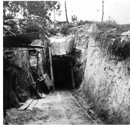
Galeria de base com carris de tipo Decauville , método de exploração habitualmente empregue em minas sobre filões estreitos. Fotografia relativa à Concessão de Alto da Bouça da Breia (Amonde, Viana do Castelo) ( Plano de Lavra , 1957 - Dossiê n.º 3146)
