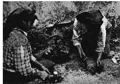
Fragmentação manual de minério em bruto, com escolha visual, antes da lavagem em bacias ou bateias. Tratamento realizado pelo "pessoal do Quilo" nas imediações da Mina da Panasqueira. Fotografia de Vaz Leal (1945).
