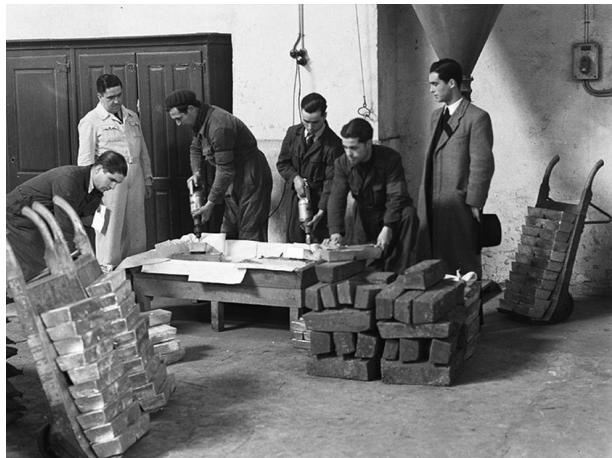
Operações de amostragem de metais em barras, pela Comissão Reguladora do Comércio de Metais (Arquivo Fotográfico da Biblioteca de Arte Fundação Calouste Gulbenkian, 1944)
