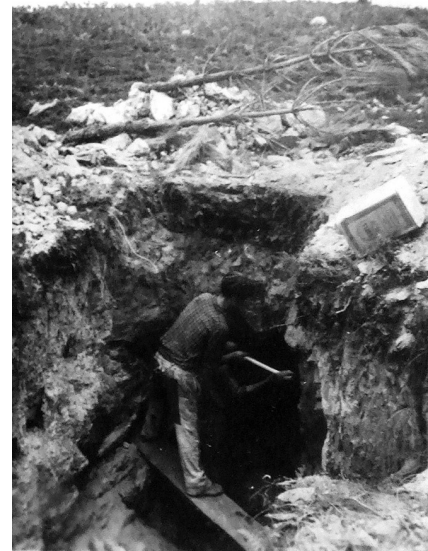
Colheita de amostras em poço sobre o filão. Fotografia relativa à Concessão de Alto da Bouça da Breia (Amonde, Viana do Castelo) (Plano de Lavra, 1957 - Dossiê n.º 3146)
