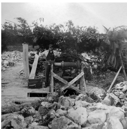
Sarilho e guincho sobre um poço vertical, área de acumulação de blocos de quartzo e aplito-pegmatito sem minério. Fotografia relativa à Concessão de Alto da Bouça da Breia (Amonde, Viana do Castelo) (Plano de Lavra, 1957 - Dossiê n.º 3146)
