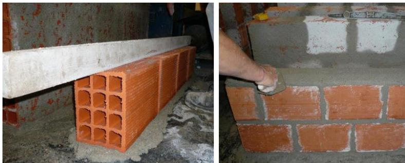
Figura 5.8 – Construção das paredes: Controlo da regularidade plana e espessura de juntas
