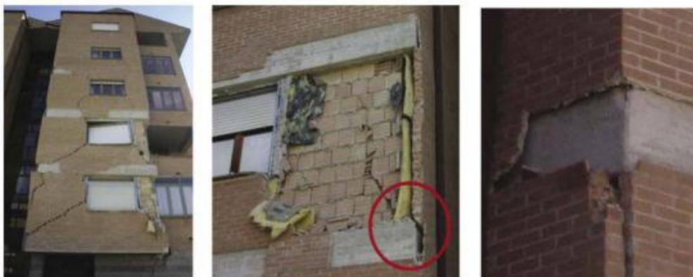
Figura 2.6 – Fendilhação e colapso de parte dos painéis exteriores [17]
