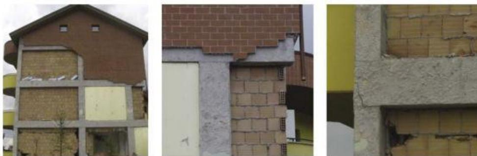
Figura 2.7 – Total desconexão do painel exterior [17]
