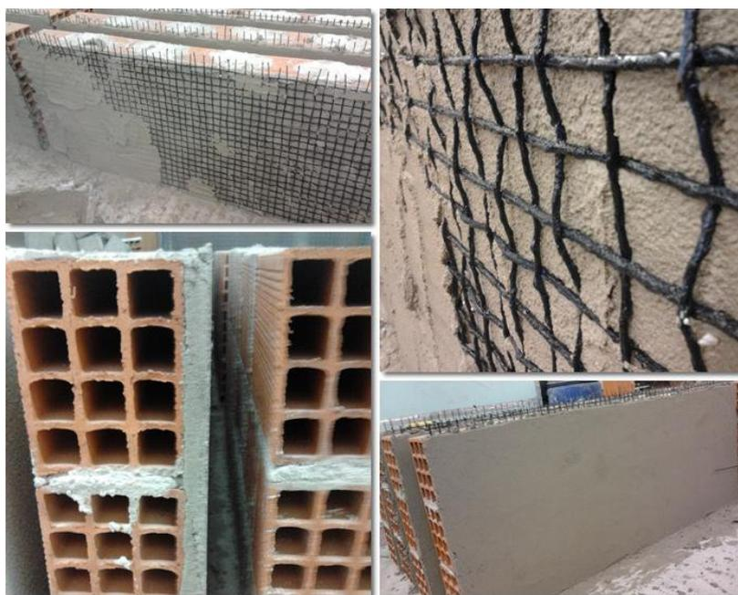
Figura 5.10 – Metodologia de aplicação das malhas de reforço
