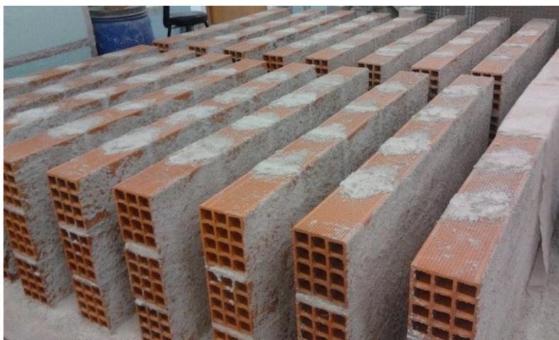
Figura 5.9 – Fase final da construção das paredes: aplicação do chapisco
