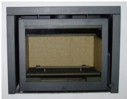
Figura 27 – Recuperador de calor da lareira instalado na sala comum do Edifício A.
