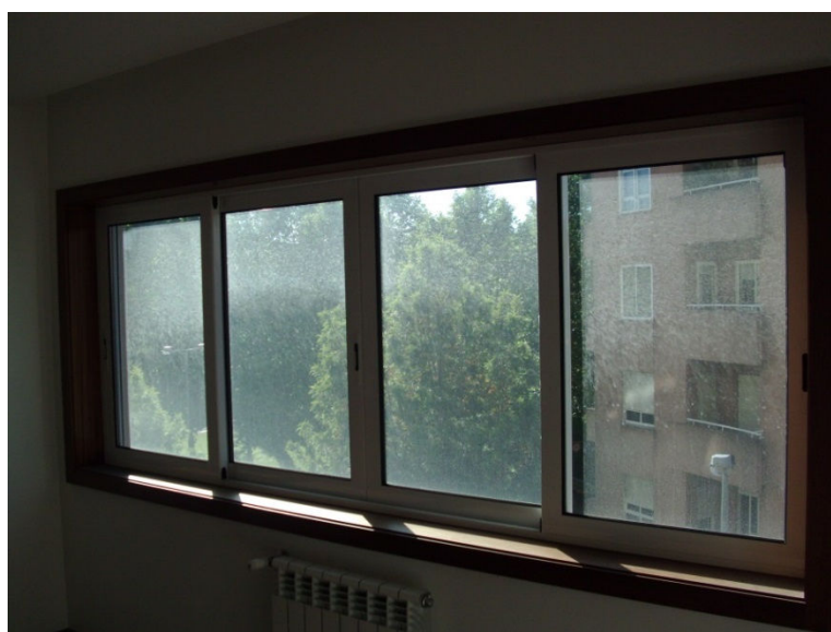
Figura 24 – Caixilharia em alumínio da fachada principal do Edifício A.
