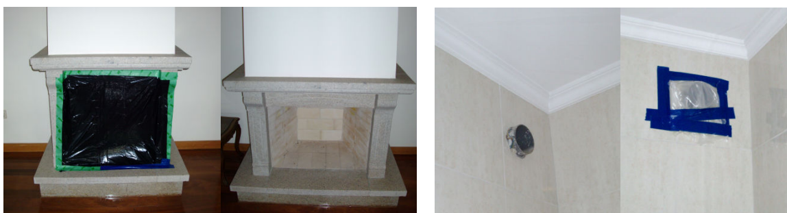
a) Chaminé selada e aberta
