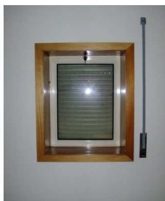
Figura 30 – Caixilharia basculante em alumínio da fachada orientada a Nordeste do Edifício B.
