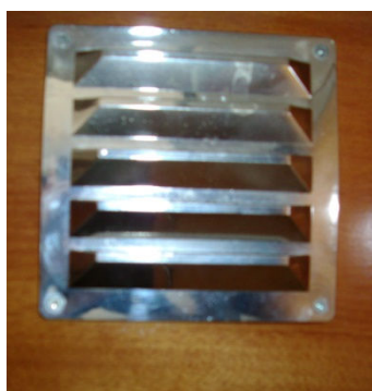
Figura 31 – Grelha de exaustão e admissão de ar no Edifício B.
