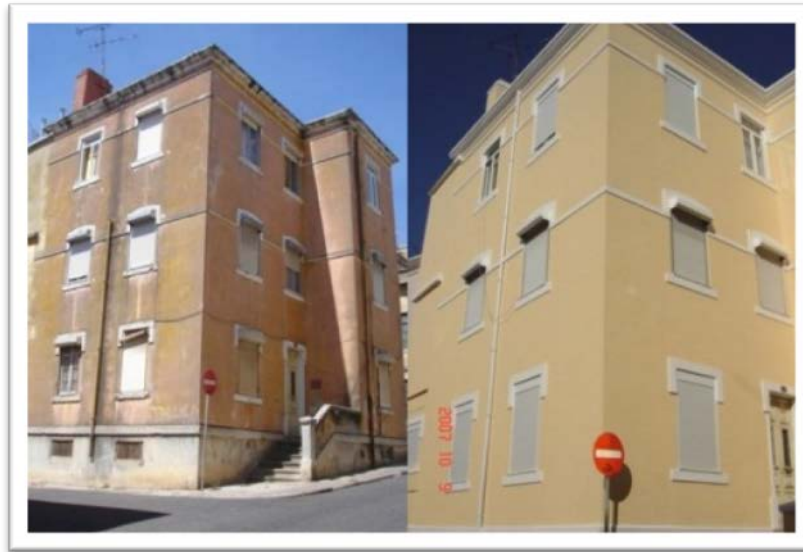
Figura 16 – Intervenção num edifício na Travessa da Verbena em Lisboa (Fonte: Lisboa Ocidental SRU, 2012a)
