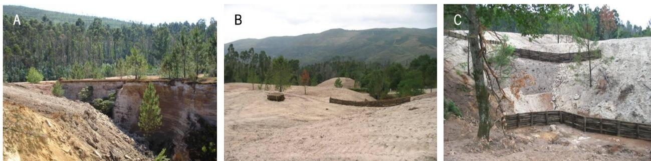
**Figura V. 140.** Perspectiva de um dos principais ravinamentos da escombrela de Valdarcas alvo de reabilitação ambiental (2007) durante a obra (A) e após (B); instabilização física de vertentes (C).
