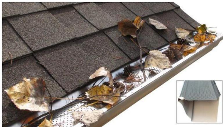
Figura 8: Grelha na calha para filtração de materiais grosseiros (RH, 2010)
