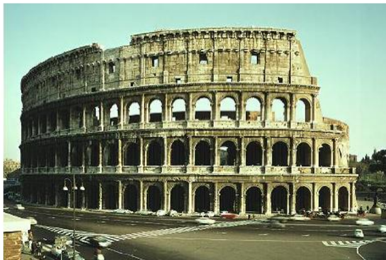
Figura 3.1 – Perspectiva do Coliseu de Roma, onde terá sido usada argamassa geopolimérica no miolo das paredes exteriores, há perto de 2000 anos (Osório, 2006).
