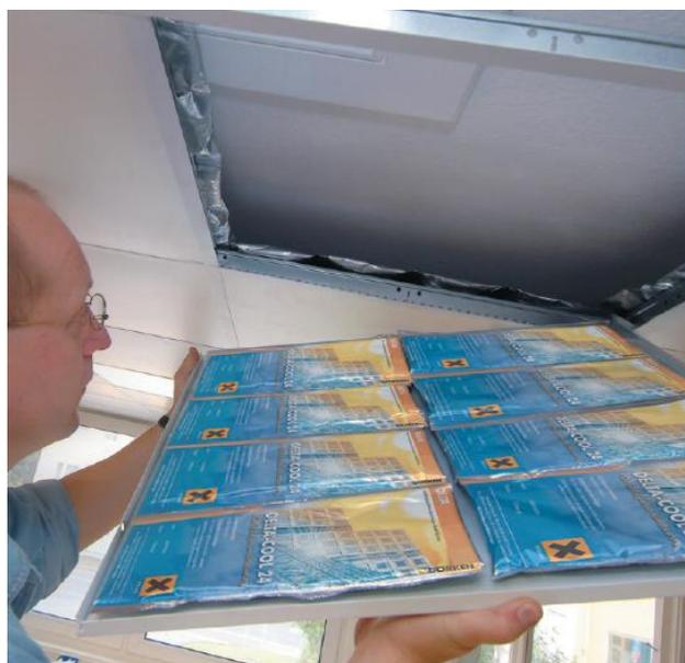
Figura 15 – PCM colocado em tetos interiores [41].
