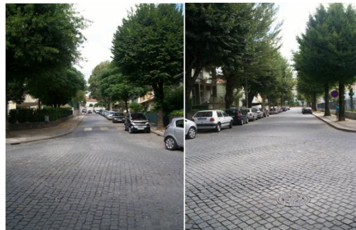
Figura 4.14 - Rua Martins Sarmiento com uma via de tráfego (esquerda); Rua Martins Sarmiento com duas vias de tráfego (direita)
